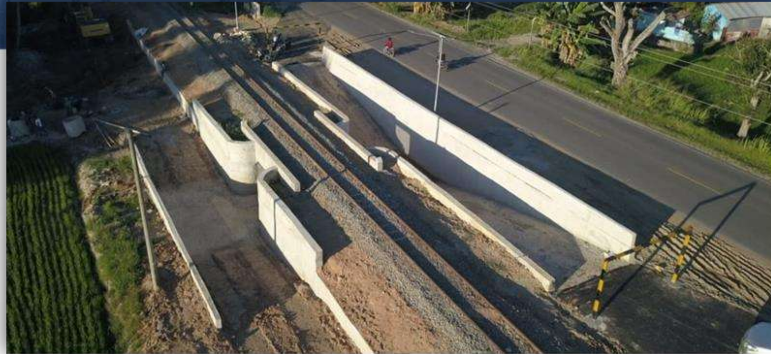
Pembangunan Underpass lintas Bandar Tinggi – Kuala Tanjung
